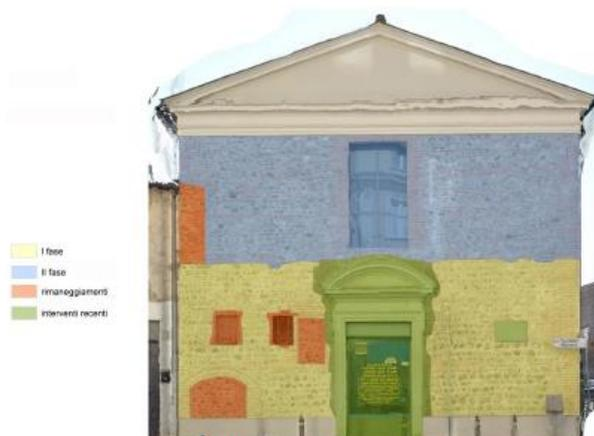
Figura 21: lettura stratigrafica del paramento ovest.
